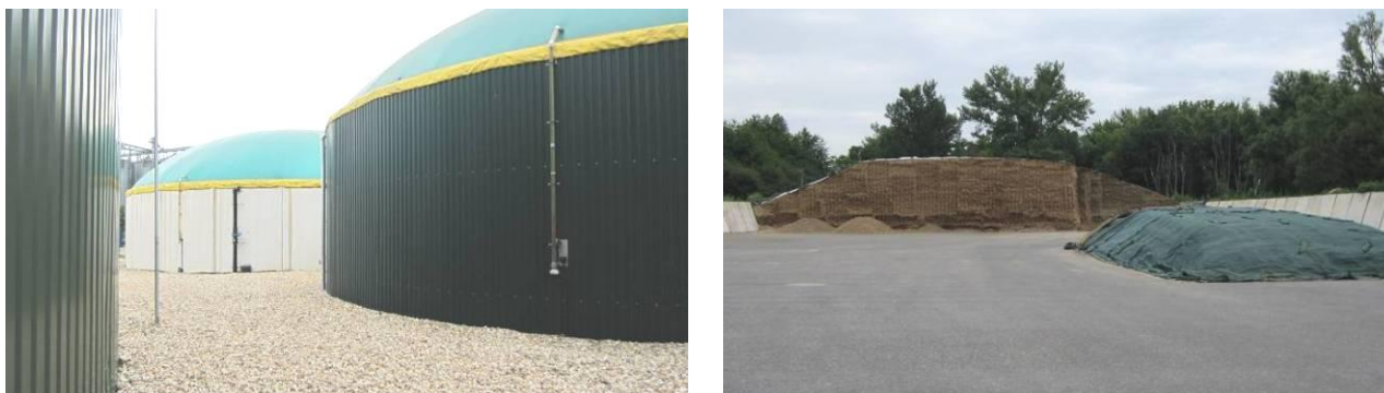
Sl. 2.1 Detalji jednog poljoprivrednog biogas postrojenja, fermentori, skladište ostatka fermentacije i trenč silos
