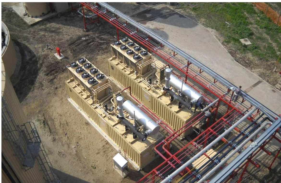
Sl. 2.3 Jedinice za kogeneraciju biogas postrojenja za prečišćavanje industrijskih otpadnih voda
