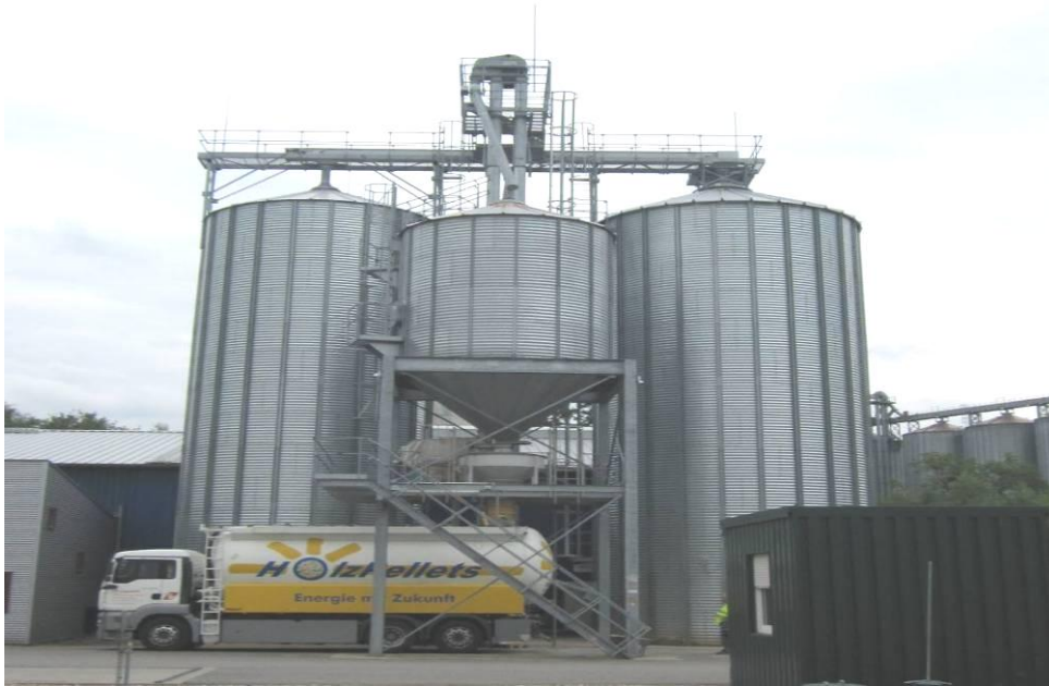
Sl. 2.4 Postrojenje koje koristi toplotnu energiju za sušenje vlažne piljevine i peletiranje, detalj skladišta za pelete
