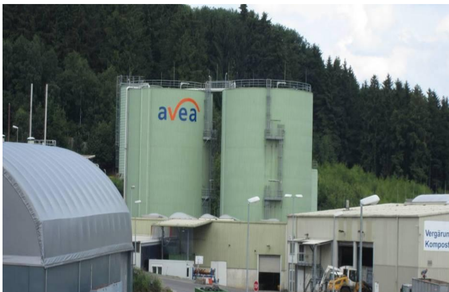
Sl. 2.2 Primer postrojenja za proizvodnju biogasa iz čvrstog komunalnog otpada
