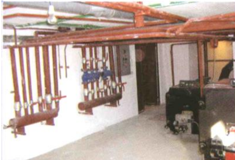
Sl. 6 Instalacija za grejanje prasilišta korišćenjem agrarne biomase
