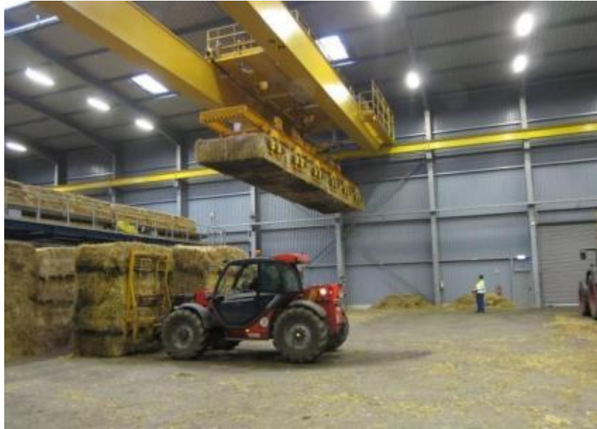
Sl. 20 Unutrašenje skladište kogenerativnog postrojenja i uređaji za automatsko loženje bala slame
