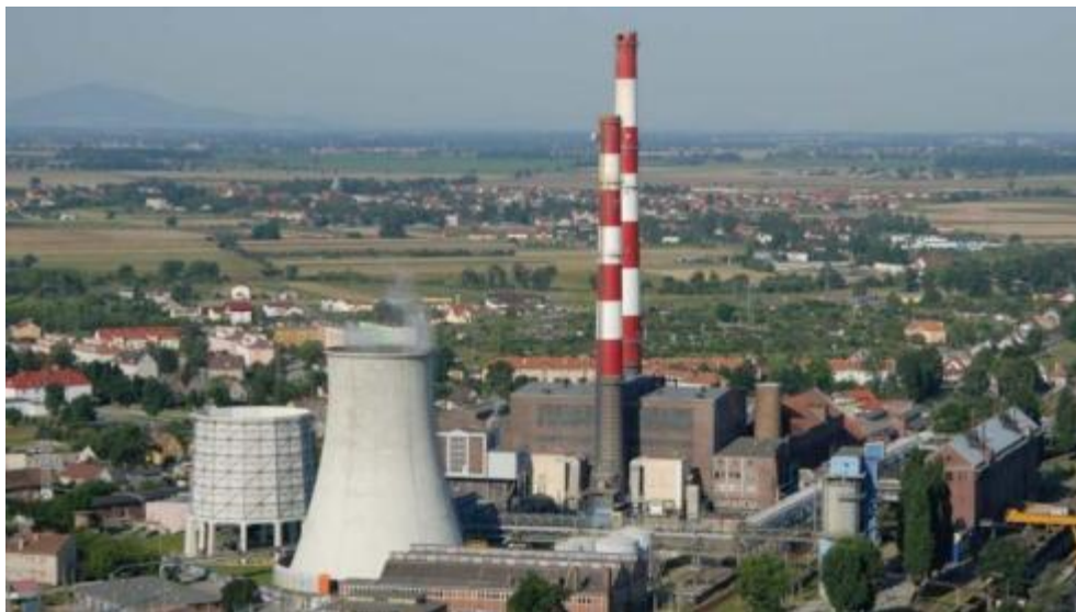
Sl. 19 Kogenerativno postrojenje Czesnica, koja za kosagorevanje sa drvenom sečkom koristi vlažnu kukuruzovinu
