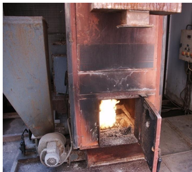
Sl. 6 Uređaj za drobljenje oklasa (opisano i prikazani rezultati efekata rada u Martinov i dr , 2011b), levo i kotao kojim se ostvaruje automatsko loženje drobljenog oklasa (doziranje pužem odozdo, takozvano ložište krtica), desno
