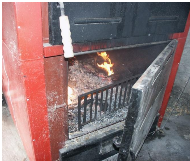
Sl. 5 Skladište goriva, oklasak i kukuruzovina, levo, jednostavno ložište za oklasak, desno
