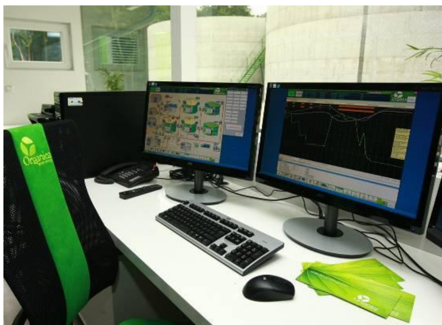
Sl. 4.9 Kontrolno-upravljačka soba za kontinualno praćenje rada postrojenja
