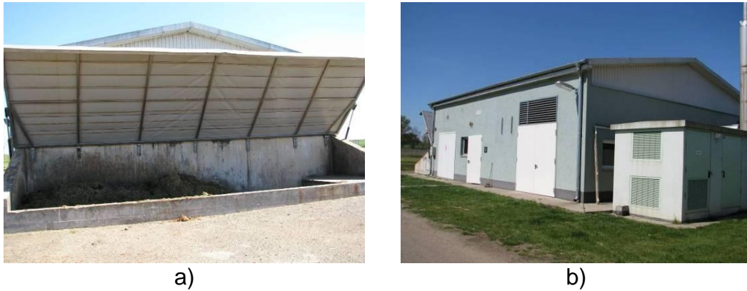
Sl. 4.15 a) Dozator za čvrste supstrate; b) mašinska kućica za smeštaj kogenerativnog postrojenja i mešača supstrata
