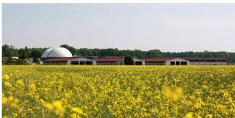
Sl. 4.6 Biogas postrojenje pored stočne farme
