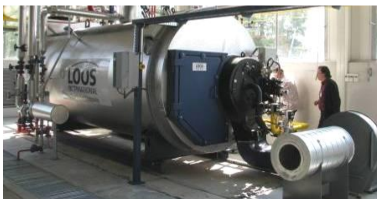
Sl. 4.26 Kotao nominalne snage 3,4 MW u kojem se sagoreva mešavina prirodnog gasa i biogasa
