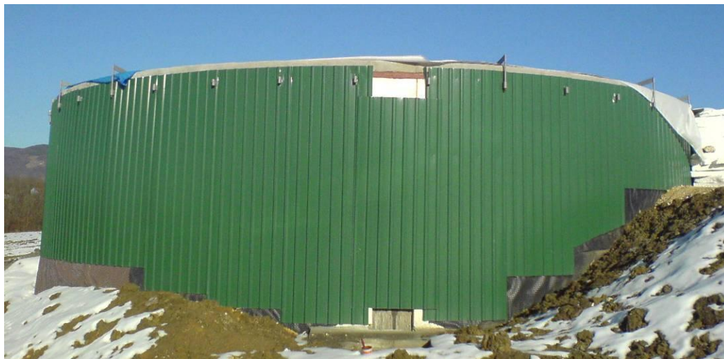
Sl. 4.19 Vertikalni betonski fermentor u izgradnji
