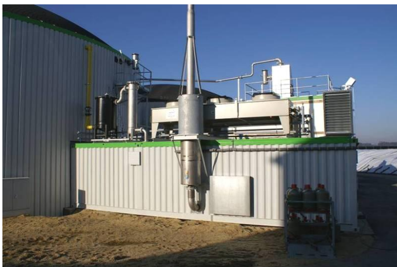
Sl. 4.4 Kogenerativno postrojenje u kontejnerskoj izvedbi
