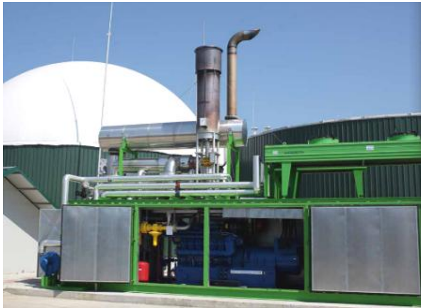
Sl. 4.7 Kogenerativno postrojenje u kontejnerskoj izvedbi električne snage 1,1 MW
