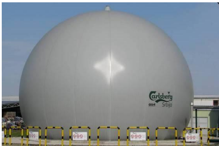
Sl. 4.25 Rezervoar za biogas (vazdušni jastuk sa duplom membranom)
