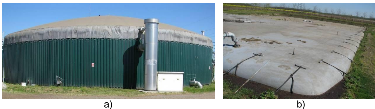
Sl. 4.14 a) Fermentor sa privremenim skladištem biogasa; b) rezervoari za skladištenje ostatka fermentacije
