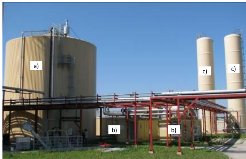
Sl. 4.22 Fermentor za hidrolizu (a), dva kogenerativna postrojenja u kontejnerskoj izvedbi (b), kolone za prečišćavanje biogasa (c)
