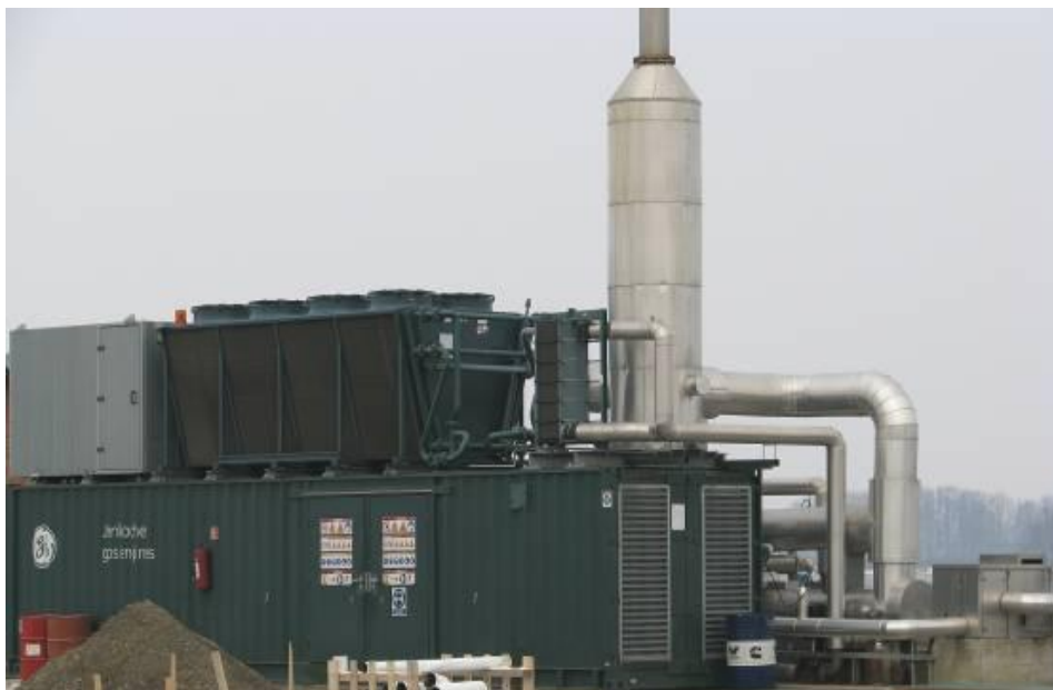
Sl. 4.12 Kogenerativno postrojenje u kontejnerskoj izvedbi Jenbacher , električne snage 2x1 MW
