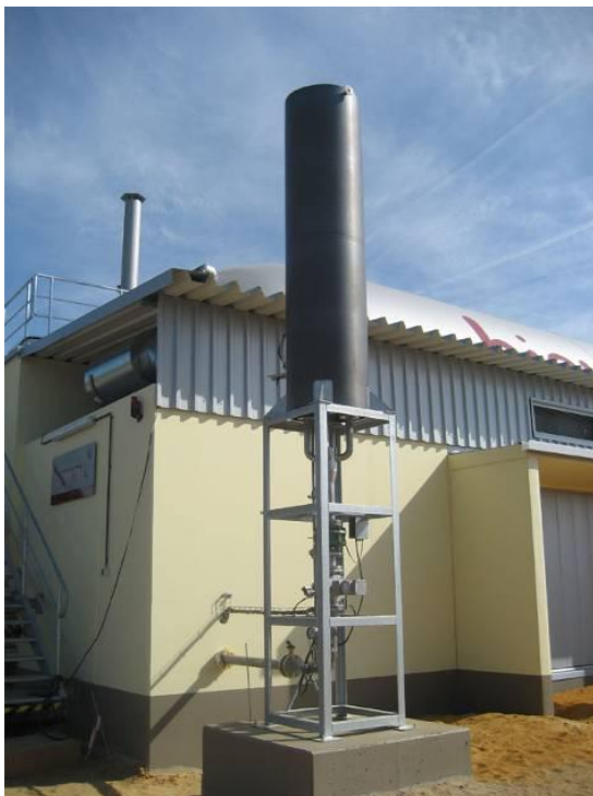
Sl. 2.12 Gasna baklja na biogas postrojenju
