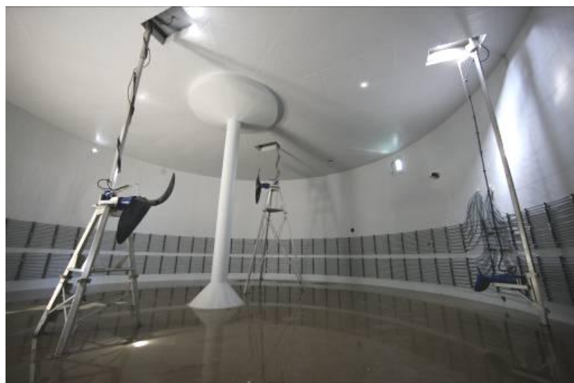
Sl. 4.8 Prikaz unutrašnjosti fermentora u izgradnji sa mešalicama i cevima za grejanje
