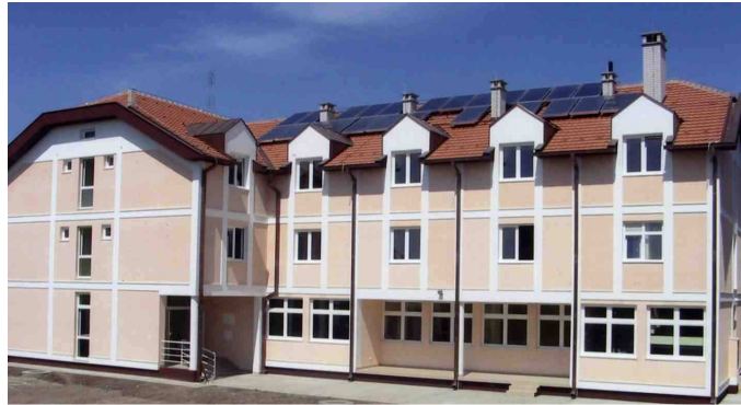
Slika 6.30. Kolektorsko polje na krovu Doma
