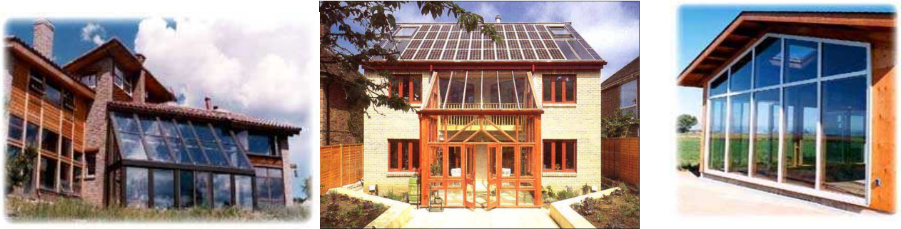
Slika 7.5. Pasivno solarno grejanje kuće sa staklenikom
