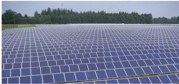
Slika 9.13. Fiksna solarna elektrana
