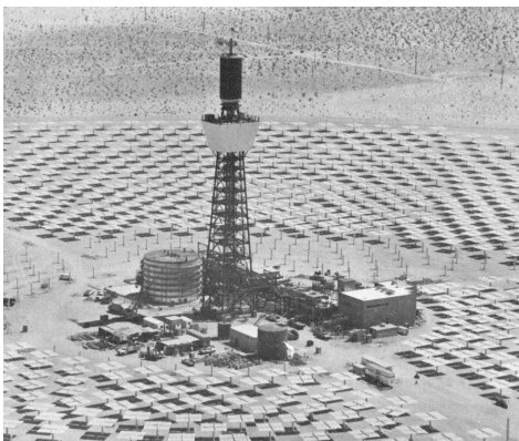
Slika 8.4. Izgled pilot makrosolarnog postrojenja snage 10 MW (Bersto-u- Kalifornija) i elementi makrosolarnog energetskeg sistema: 1 - heliostat, 2 - prijemnik - isparivač, 3 - turbina sa elektrogeneratorom, 4 - polje heliostatskih ogledala, 5 - toranj sa prijernikom, 6 - komandno odeljenje
