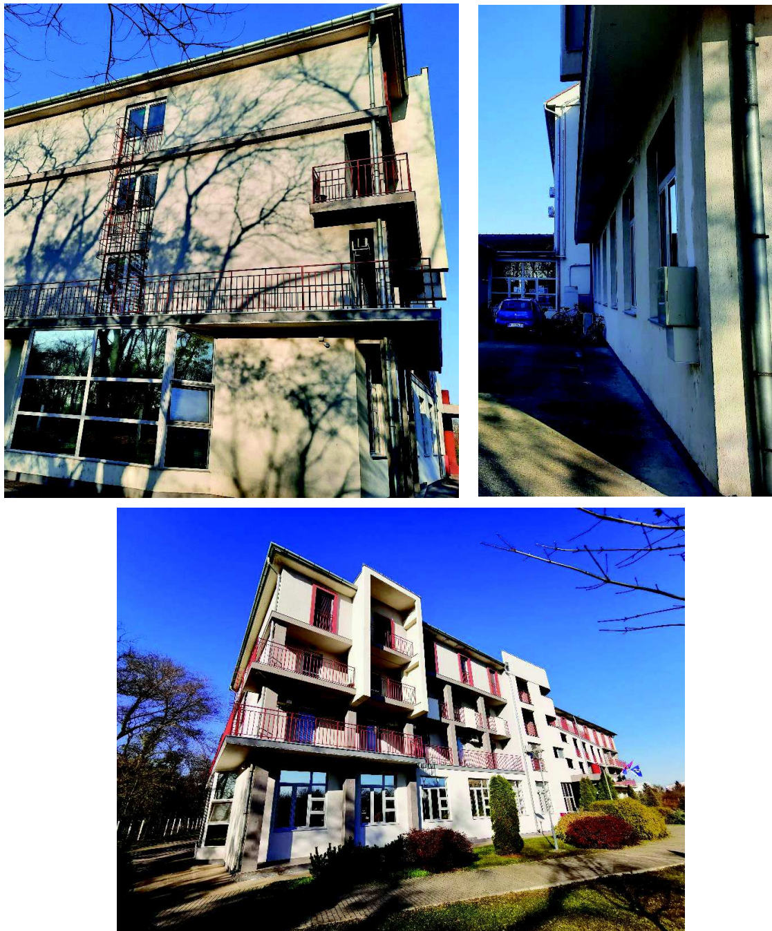
Слика 2.1 Изглед спољних зидова објекта
