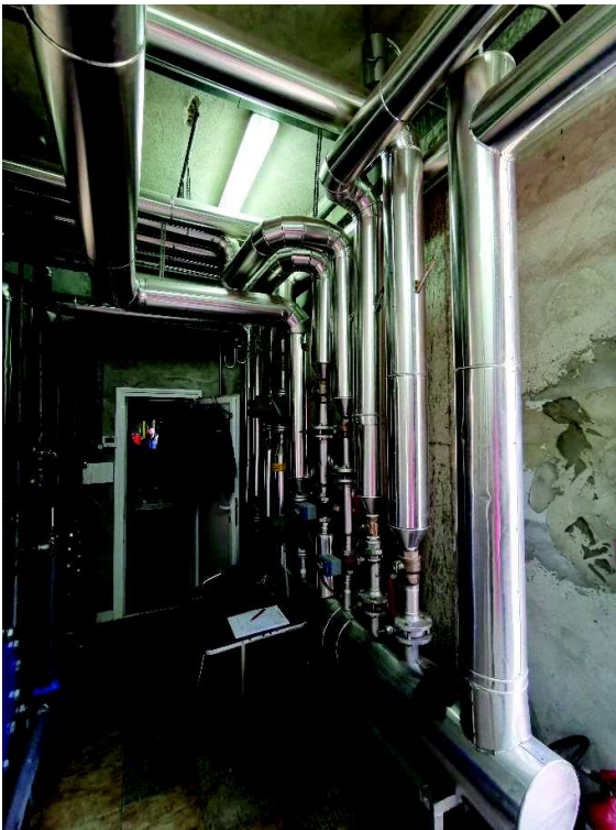
Слика 2.5а Изглед цевне мреже у котларници
