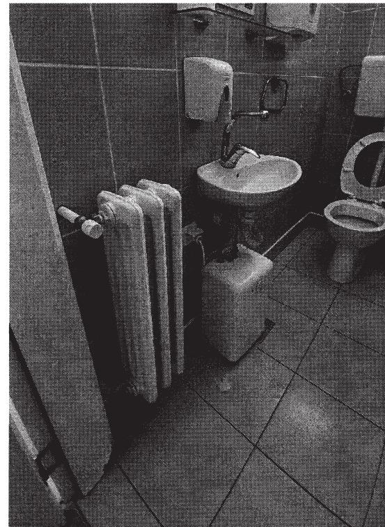
Слика 2.17 Уређај за загревање воде и ливени радијатор
