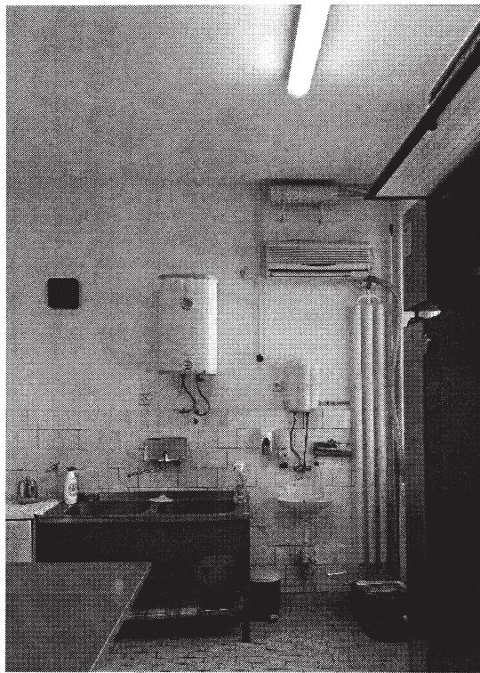
Слика 2.16 Уређај за загревање воде
