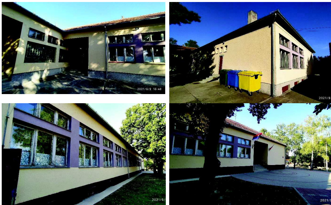
Слика 2.1 Изглед спољних зидова објекта
