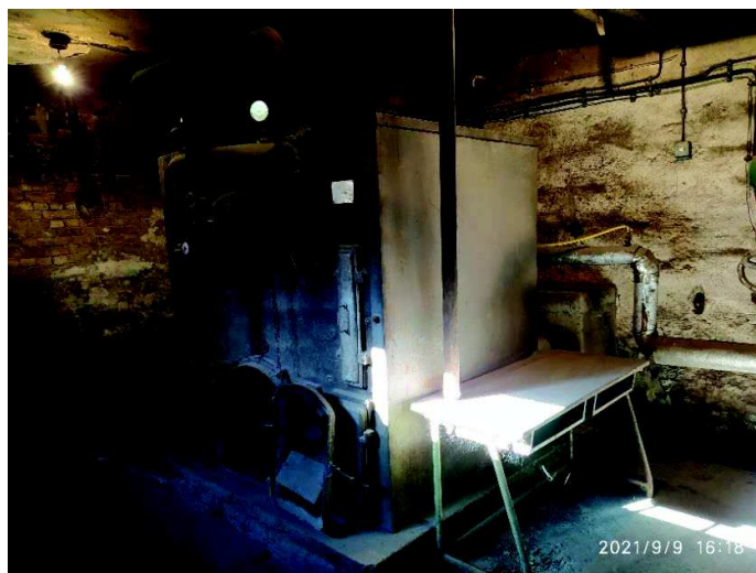
Слика 2.4 Котао на угаљ који се користи за потребе загревања простора
