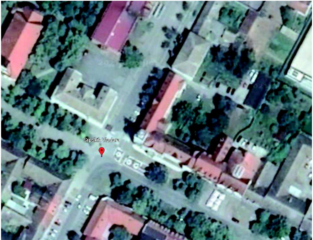
Слика 1.2 Локација објекта (извор: Google Maps )
